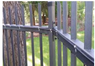
15. ábra Érzékelő kábel elrendezés téglá oszlopok közötti fa kerítésre
