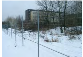
4. ábra Érzékelőkábel elrendezés keretezett, fonott dróthálóra
